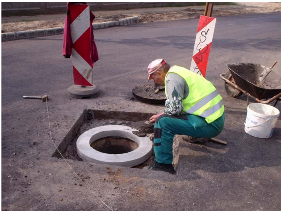
1. ábra. A csatornaszemek hagyományos beépítésének fényképfelvétele
