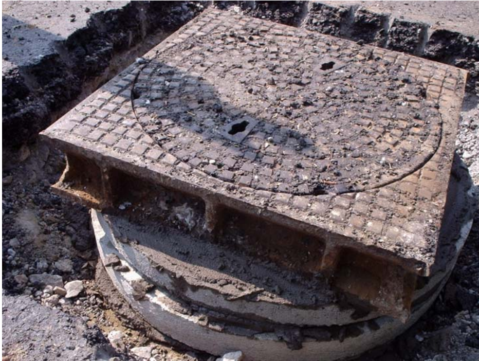
4. ábra. A hagyományos fedlapbeépítés fényképfelvétele
