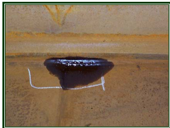
11/a.-11/b. ábra: Tipikus hibahelyek szimplafalú szénacél tartályok falán
