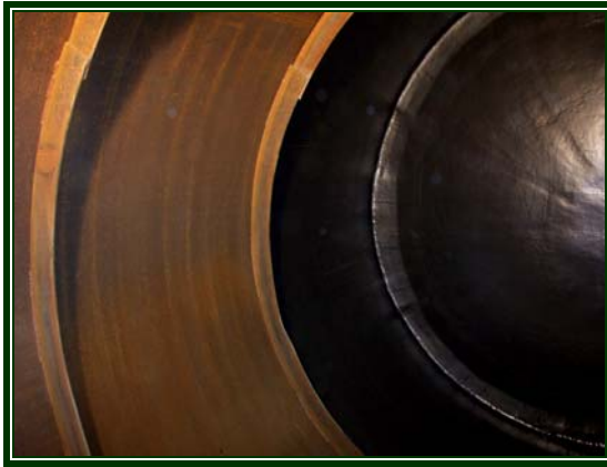
4/a.-4/b. ábra: Az első réteg kialakítása
