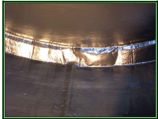
13/a.-13/b. ábra: Duplafalúsítással megszüntethetőek a korróziós, illetve technológiai hibákból eredő lyukak, minimálisra csökkentve a környezeti kockázatot
