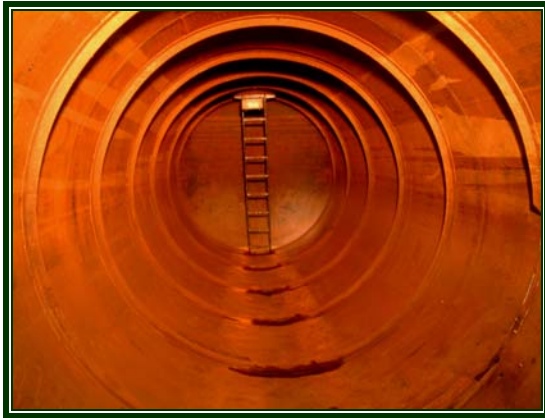
14/a.-14/b. ábra: Szimplafalú acéltartályok műanyag kompozittal való duplafalúsítási technológiája az elérhető legjobb és leggazdaságosabb technika a környezeti és műszaki biztonság eléréséhez
