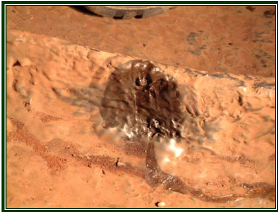
13/a.-13/b. ábra: Duplafalúsítással megszüntethetőek a korróziós, illetve technológiai hibákból eredő lyukak, minimálisra csökkentve a környezeti kockázatot
