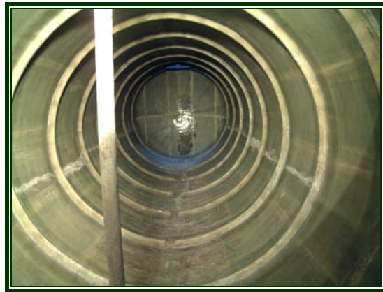
14/a.-14/b. ábra: Szimplafalú acéltartályok műanyag kompozittal való duplafalúsítási technológiája az elérhető legjobb és leggazdaságosabb technika a környezeti és műszaki biztonság eléréséhez
