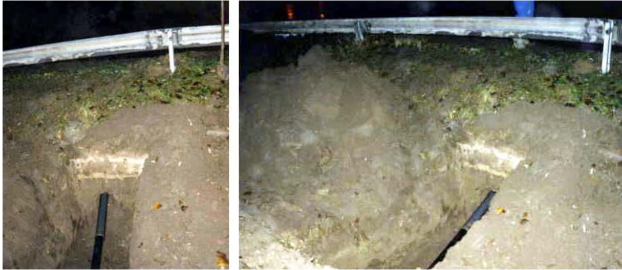
Útburkolat kímélő csőfektetés rakétás (Grundomat) fúrással
