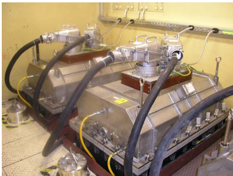
2. ábra Co-izotóp eltávolító, komplex-bontó berendezés képe a Paksi Atomerőmű Rt. primer körében
